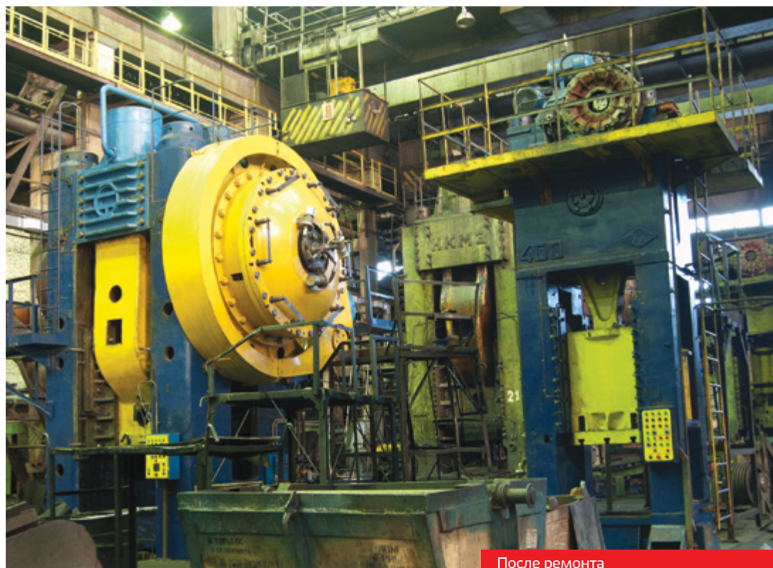
После ремонта After repair
