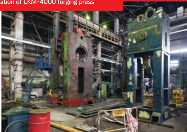
Ремонт и модернизация ковочного прессы ЛКМ-4000 Repair and modernization of LKM-4000 forging press
